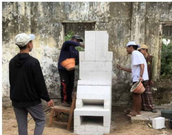
Gambar 1. Proses Pembangunan Incinerator
